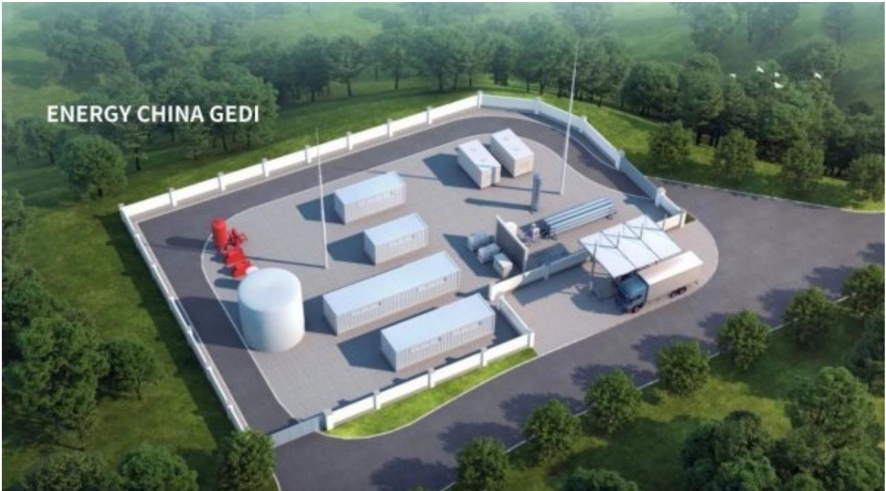
此次中标的项目，建设包括制氢规模为1.25兆瓦（250标准立方米/小时）AEM制氢设备1套、储氢系统1套、压缩系统2套、35兆帕加氢机1台，以及制氢加氢一体站其他附属设施。广东院牵头的联合体，将负责工程设计、设备采购、施工、试验、调试、试运行、培训、验收及档案资料移交等全过程工作。
