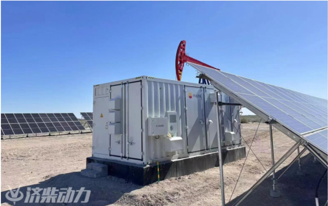
该智能微网系统配备了2台锌溴液流电池储能系统和5台磷酸铁锂电池储能系统，容量达1354千瓦时，是中国石油首个锌溴液流电池储能系统项目，可满足离网型边远井场4至24小时储能时长，以及冬季零下25摄氏度低温放电的实际需求。
