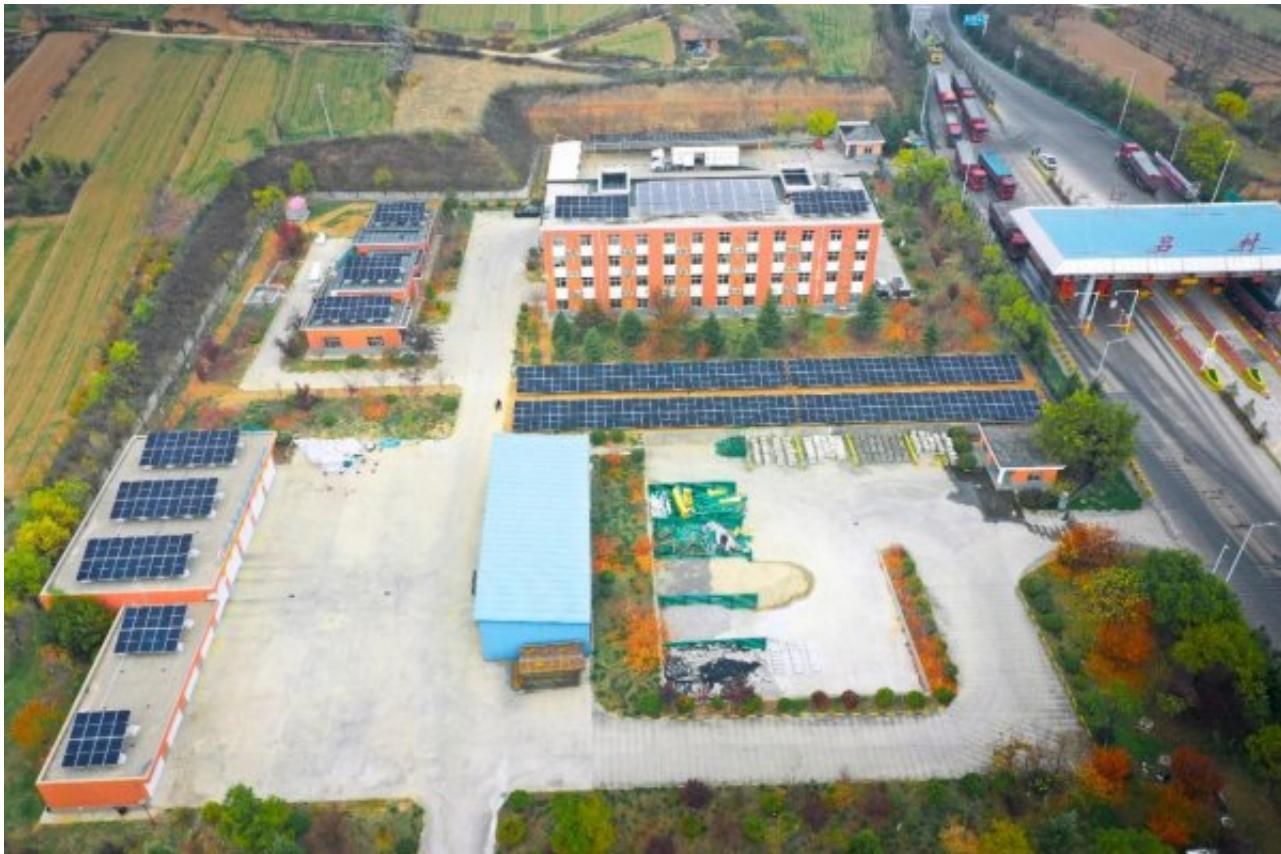
作为高速公路路域分布式光伏发电项目（第一期）中首个并网发电的项目，2个站点充分利用收费站屋顶及闲置地面1979平方米，建设0.41MW分布式光伏电站，采用“自发自用，余量上网”模式消纳电能。投运后可每年提供清洁能源约38.98万度，相当于每年节约标准煤124.72吨，减少二氧化碳排放317.27吨。
