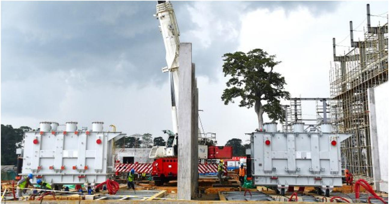
11月20日，中国能建建筑集团、国际集团以联营体EPC模式承揽的科特迪瓦46兆瓦生物质电站项目两台主变压器就位，为下一步实现倒送电节点奠定了坚实基础。
