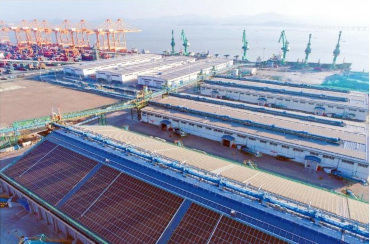
该项目由厦门港务控股集团权属海纳特电(厦门)新能源科技有限公司和厦门海隆码头有限公司合作建设。项目利用海隆码头1号-6号仓库约6万平方米的屋面，采用“常规组件+导水槽+彩钢瓦”模式和“可拆柔性组件+玻璃钢复合瓦”模式，分两期建设并网。
