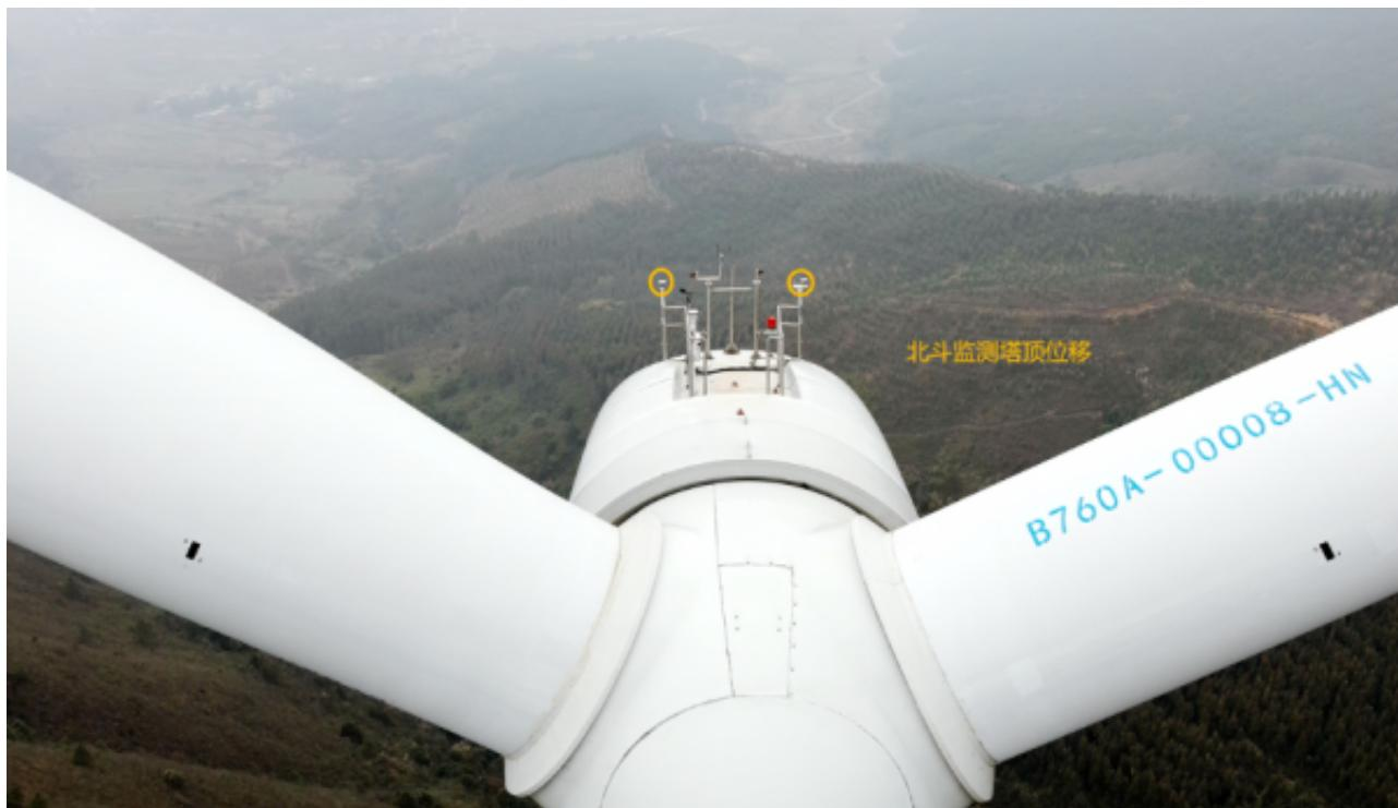
本项目依托北斗双天线位姿监测、单北斗监测以及无线智能感知技术取得的成果，深入分析风机结构及运行特点，结合在数据挖掘行业模型，构建了基于北斗卫星高精度便携定位技术的风机基础安全监测体系，实际了云-边-端一体化的实时感知风机塔顶的摆动轨迹、塔筒的倾斜状态、塔基的基础沉降情况等参数，实现在风电场升压站对所有的风机塔筒参数的汇集、分析和展示。
