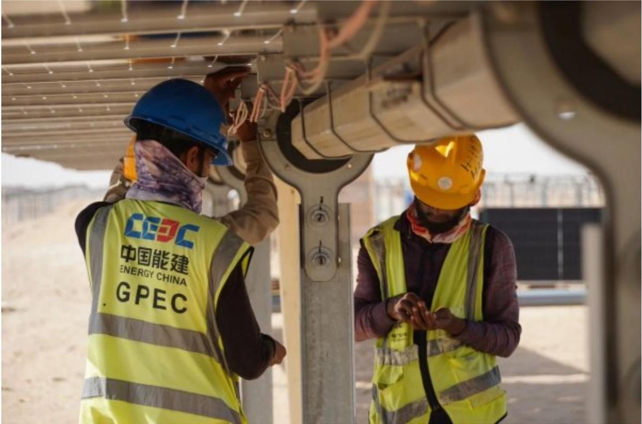
在不到八个月时间里，项目快速完成了81余万根桩基的安装。500多万片光伏面板，如同沙漠中的蓝莲花，绽放在沙丘之上。项目在带动中国设备、中国技术“出海”的同时，也为不同企业国际合作搭建平台。“我们的支架由西班牙和中国两家公司同时供货。这种跟踪式支架能根据太阳的位置自动调整光伏板角度，使光伏板始终朝向太阳方向，从而较大限度地提高光伏发电效率，支架的抗风性能也不错”。熊高峡介绍，项目使用的消防设备来自德国，监控系统由沙特企业生产，线塔全部进行本地采购，组件、逆变器、自动清扫机器人等设施、设备全部来自中国。阿尔舒巴赫光伏电站广泛应用数字化、智能化技术，建成后将实现无人化运行。
