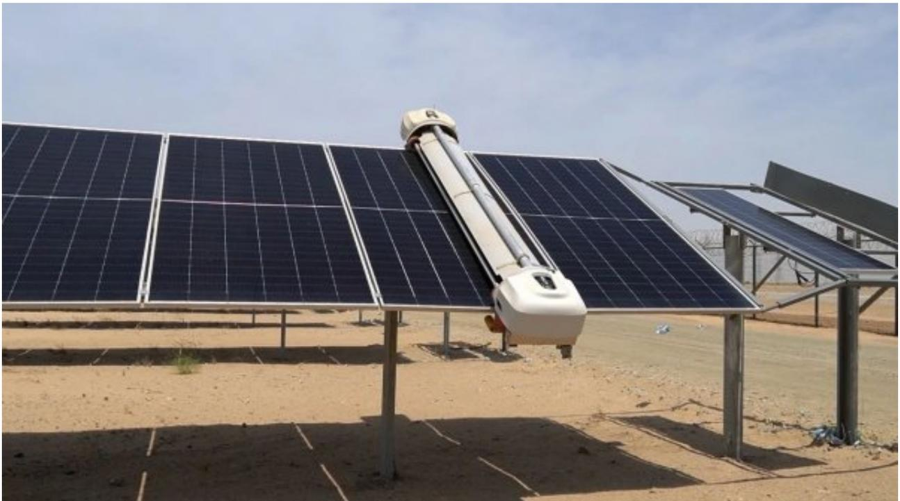
“项目采用全球最先进N型双面光伏组件和平单轴自动跟踪式支架，可以精准、最大化地吸收阳光的能量。自动清扫机器人确保每一片面板都能以最佳状态迎接阳光的洗礼，先进的PPC控制系统则如同智慧的大脑，指挥着整个电站的运作”，中国能建国际工程公司副总经理兼项目经理熊高峡介绍。
