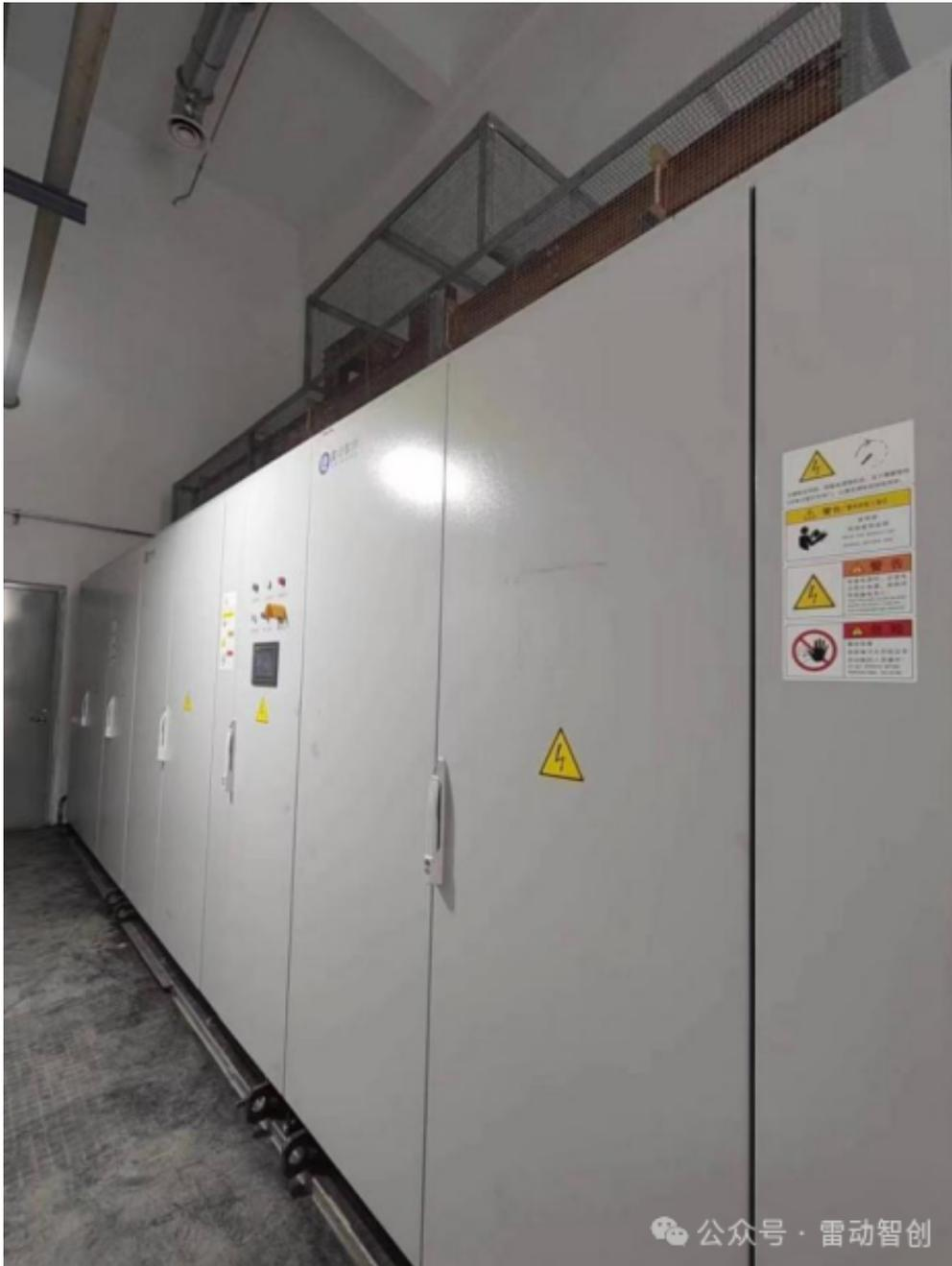
截止目前，雷动智创研制的IGBT制氢电源已累计运行超过数百小时，顺利完成各种性能测试，性能优异。经测试：额定负荷下效率 97.5%；功率因数达到0.99以上；100%负荷下电流THD 1.4%；额定负荷工况下输出电流纹波系数0.68%，输出电流控制精度0.15%；关键技术指标均达到业内领先水平。此外，制氢系统在快速响应和过载性能上表现同样出色，现场完成了负荷变载从0.5%/秒至10%/秒不同电流变化率的测试，并完成120%额定电流稳定运行测试。
