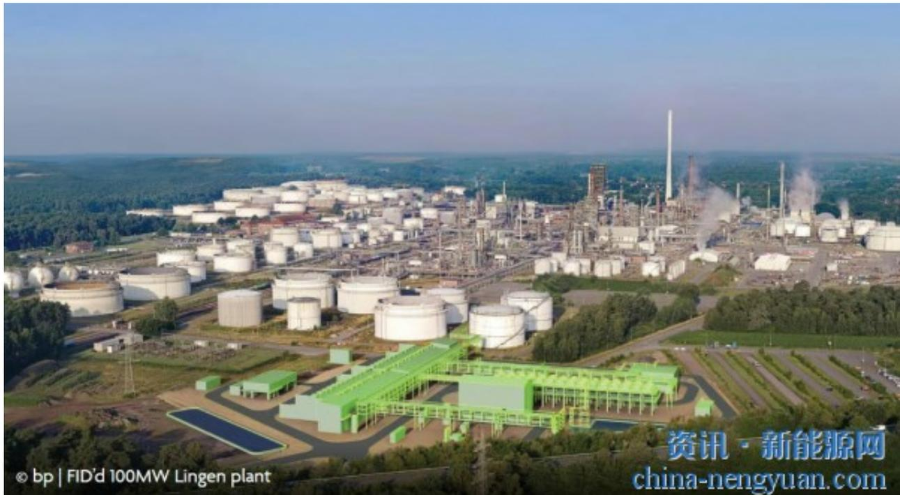
康明斯的清洁技术部门Accelera透露，它将为英国石油公司（BP）位于德国林根的绿色氢工厂提供100MW的质子交换膜电解槽系统。
