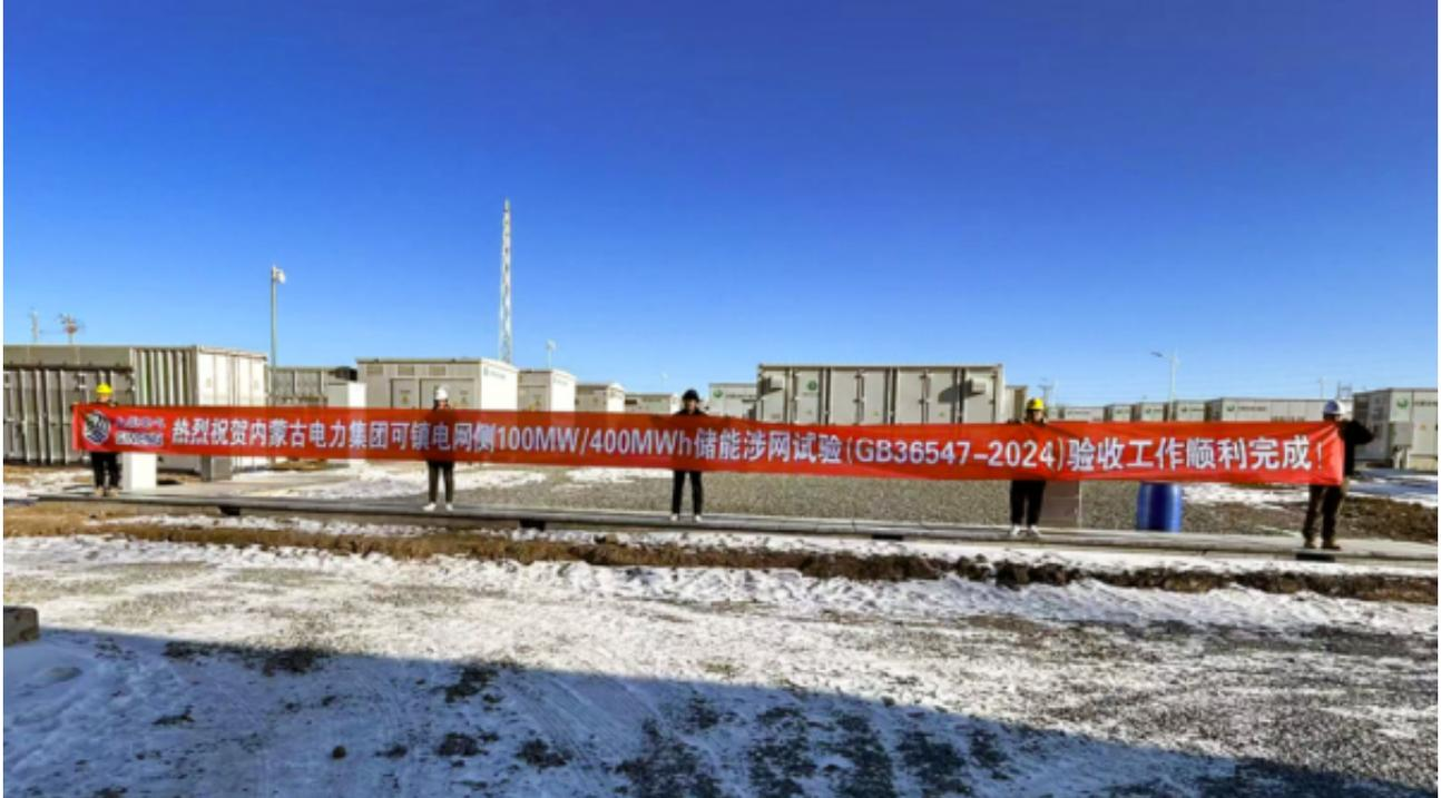
该储能电站坐落于呼和浩特市武川县内，上能电气为其提供5MW集中式变流升压一体机系统解决方案，采用4台新一代1250kW集中式储能变流器直接并联，可实现整个储能场站效率性能的跃升。
