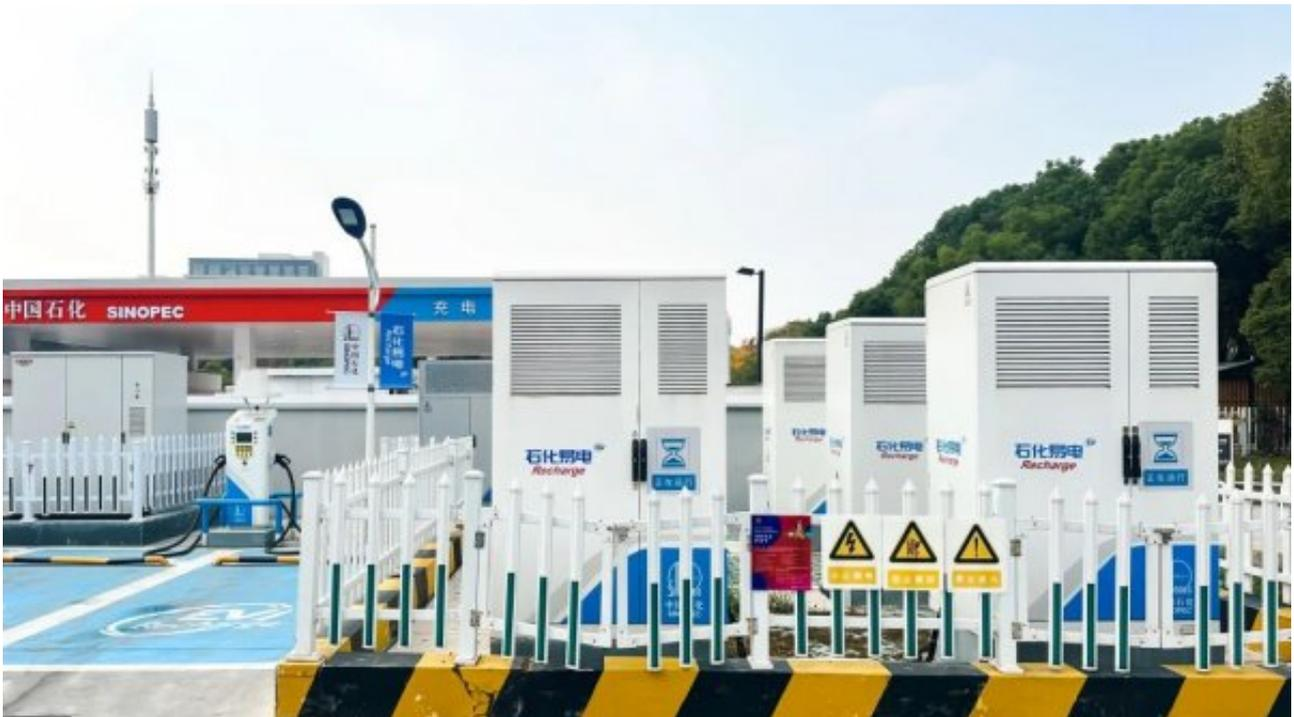
光储充一体化即光伏、储能、充电一站式应用。该模式不仅可以解决未来更多更大功率电动汽车充电对电网的功率冲击问题，也能解决光伏发电平稳输出问题，满足城市用电负荷动态平衡需求。随着电动汽车越来越多，光储充一体化在城市充电站、高速公路服务区、工业园区等场景应用将越来越多。
