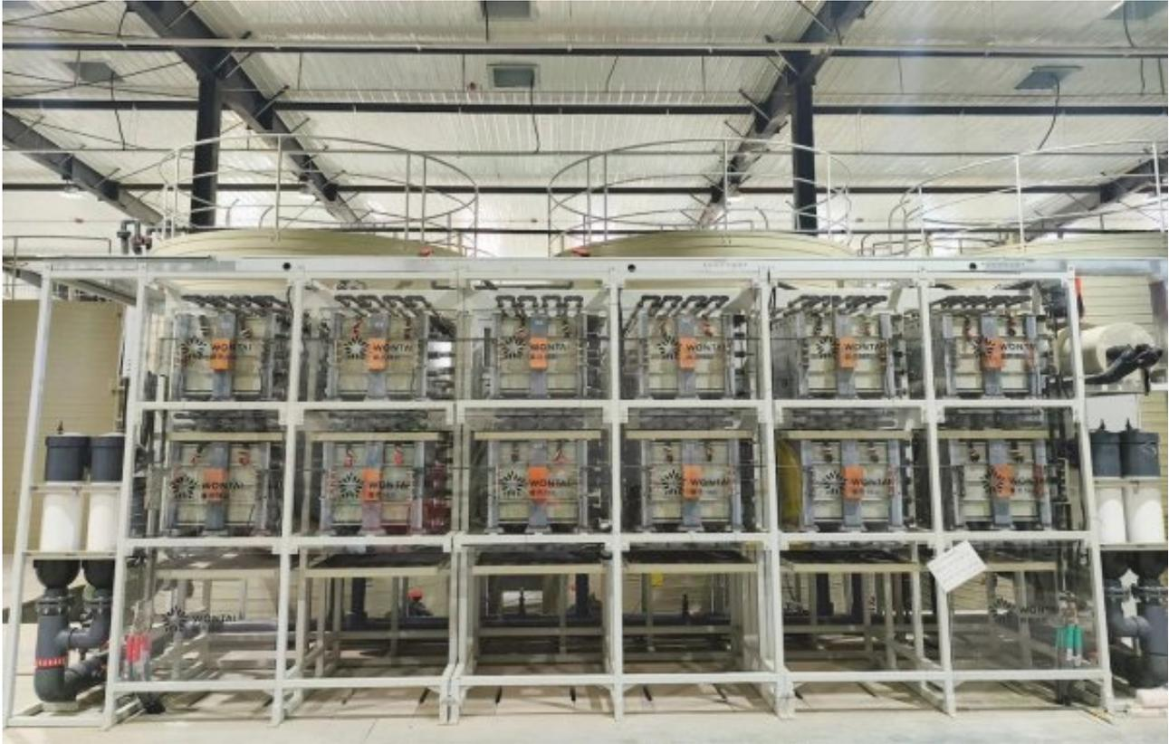
该储能电站位于酒泉市瓜州县北大桥新能源规划区内，是今年初并网的寰泰瓜州北大桥白杨100MW风电场的配套储能项目。厂区共建有6个2.4MW储能单元和1个0.6MW储能单元，采用寰泰储能研发制造的全钒液流电池系统，可在-35 至45 的环境温度下稳定运行，使用寿命长达25年，深度充放电次数高达2万次。由于使用低酸浓度水系电解液，电池系统无燃烧、爆炸风险，安全可靠，绿色环保。
