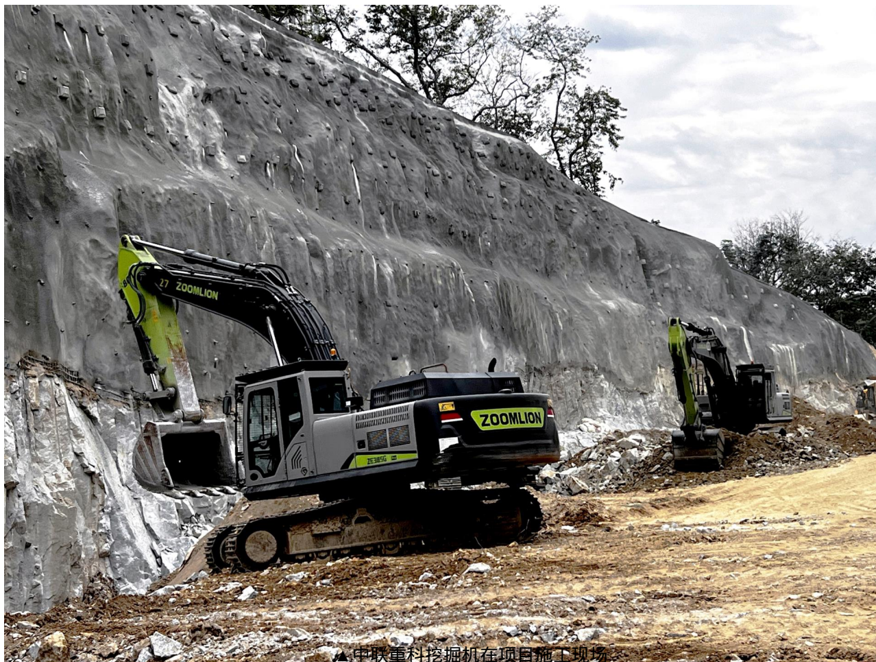
▲中联重科挖掘机在项目施工现场
