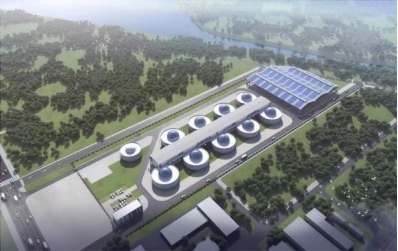
本项目位于江苏省泰州市靖江开发区，项目总投资约6,000万元，占地约80亩，设计规模为年产绿色天然气1,000万立方，每年可处理生物质约5万吨，减少碳排放约1.2万吨。项目采用高温多物料厌氧发酵技术为核心工艺，结合干法脱硫、化学脱碳、深度脱水等先进技术，最终通过管网形式供气，确保能源高效清洁利用。作为生物质能源领域的示范项目，其成功实施将助力光大绿色环保进一步拓展生物质高值化利用市场，同时为传统冶金行业提供绿色转型配套设施样板。
