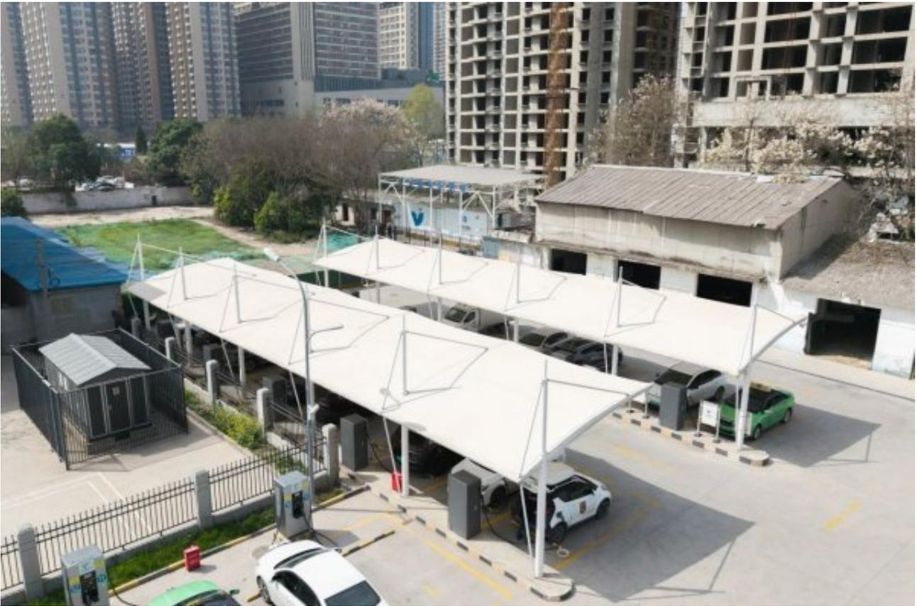
丈八北路“光储充”项目于2024年5月开工建设，设置有100.08kWp分布式光伏、125kW/500kWh全钒液流电池储能系统和20台双枪快充充电桩，年平均发电量9.7万度，相当于节约标准煤29.1吨，减排二氧化碳79.6吨。
