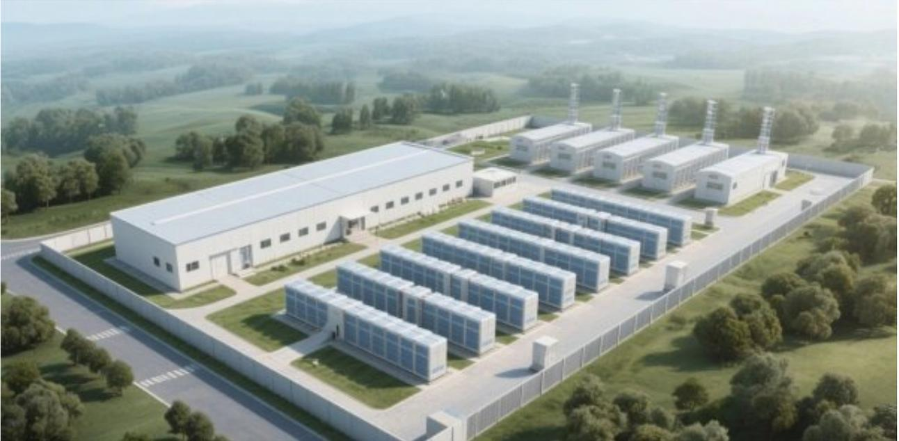
南京溧水经济开发区5万千瓦/10万千瓦时二期储能电站项目，基于磷酸铁锂电池技术建设独立新型储能电站。项目计划与一期合并建设，总计规模100MW/200MWh，拟采用220KV电压等级接入，计划2025年7月中旬并网投运。
