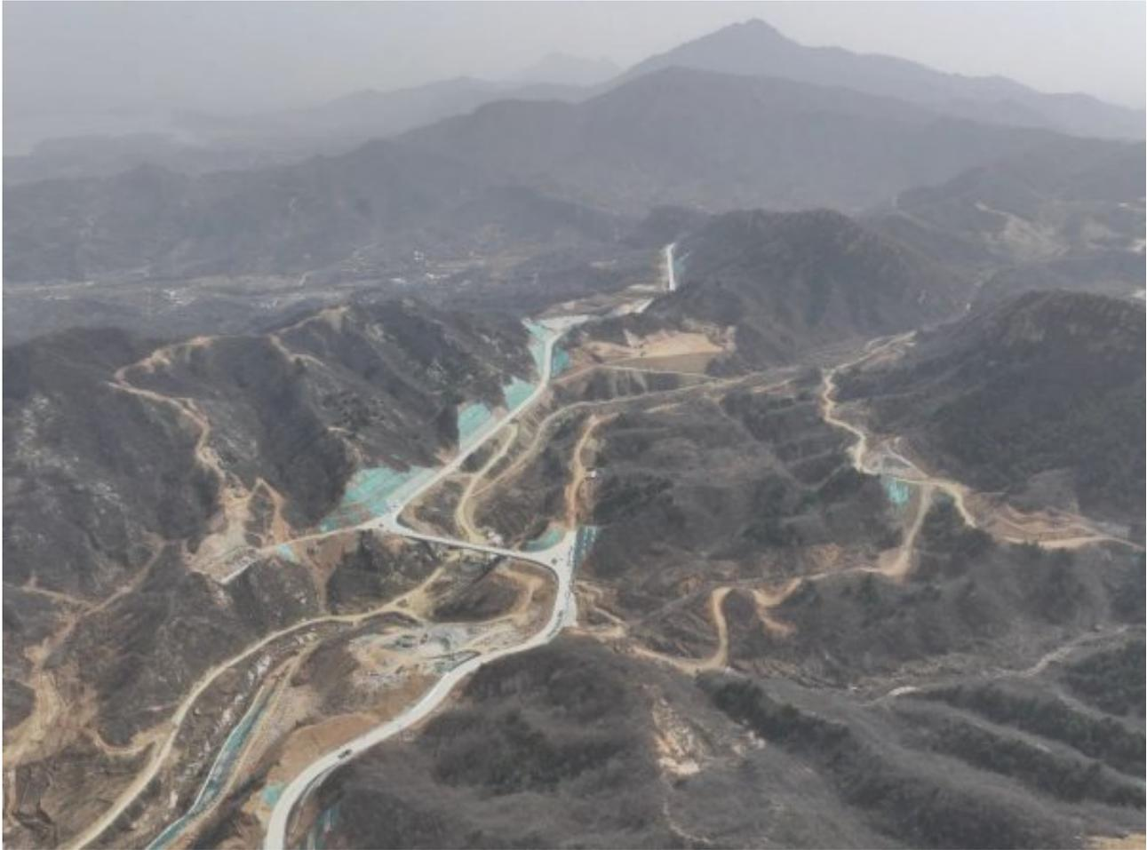
灵寿抽水蓄能电站位于河北省石家庄市灵寿县寨头乡，枢纽工程主要建筑物由上水库、输水系统、地下厂房及开关站、下水库等部分组成。电站总装机容量140万千瓦，额定发电水头605米。项目施工范围包含：引水高压管道、尾闸室、尾水调压室、尾水隧洞，地下厂房、主变洞等地下洞室群。
