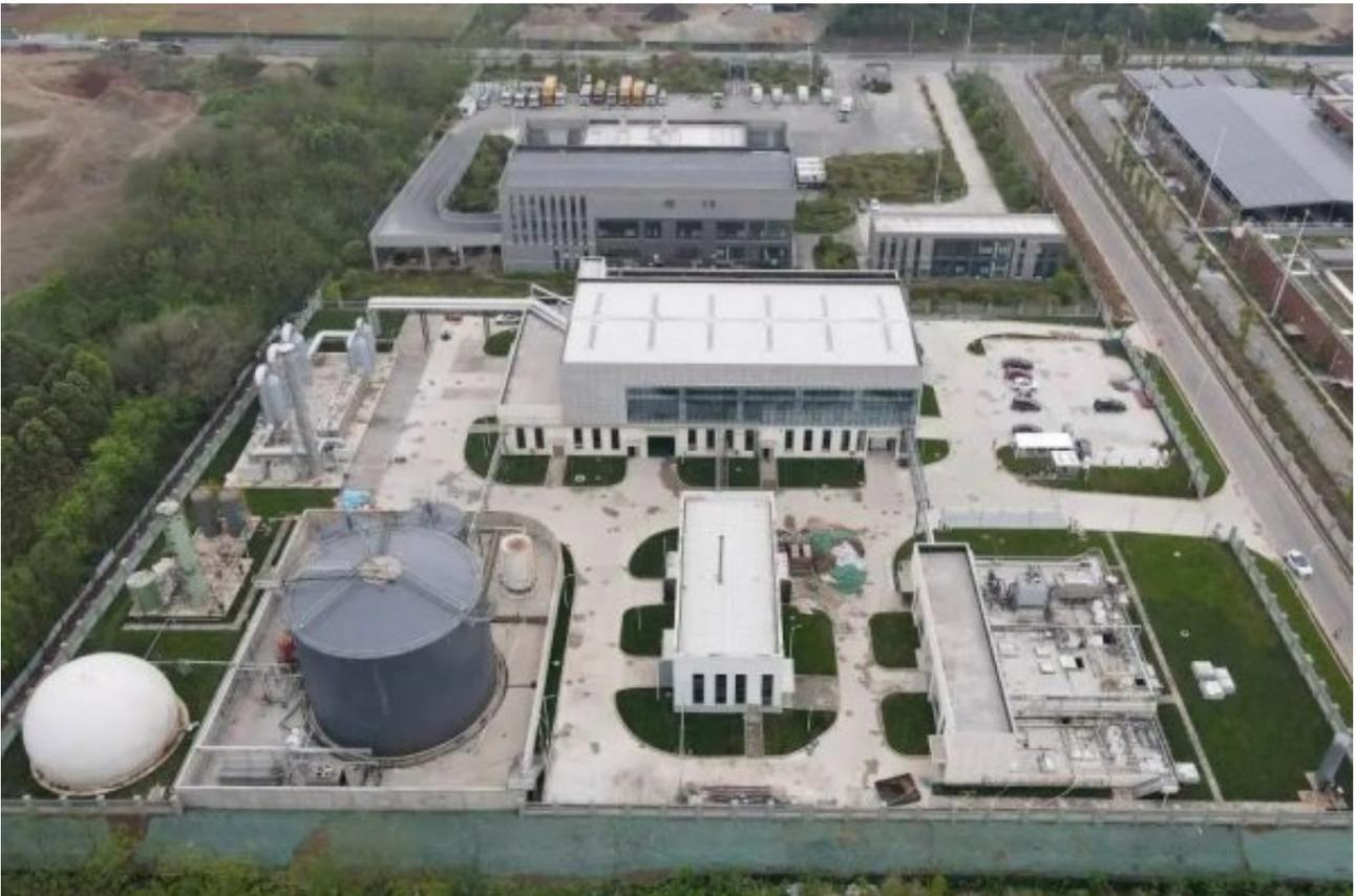
真正的“魔法”发生在占地5000立方米的厌氧发酵罐里。在38℃恒温环境中，微生物将有机质分解为沼气，每日产气7000立方米，经生物脱硫后驱动发电机组，年发电量达394.43万千瓦时，不仅满足厂区80%用电需求，剩余电量输送至污泥处理厂，相当于年节约标准煤1200吨。
