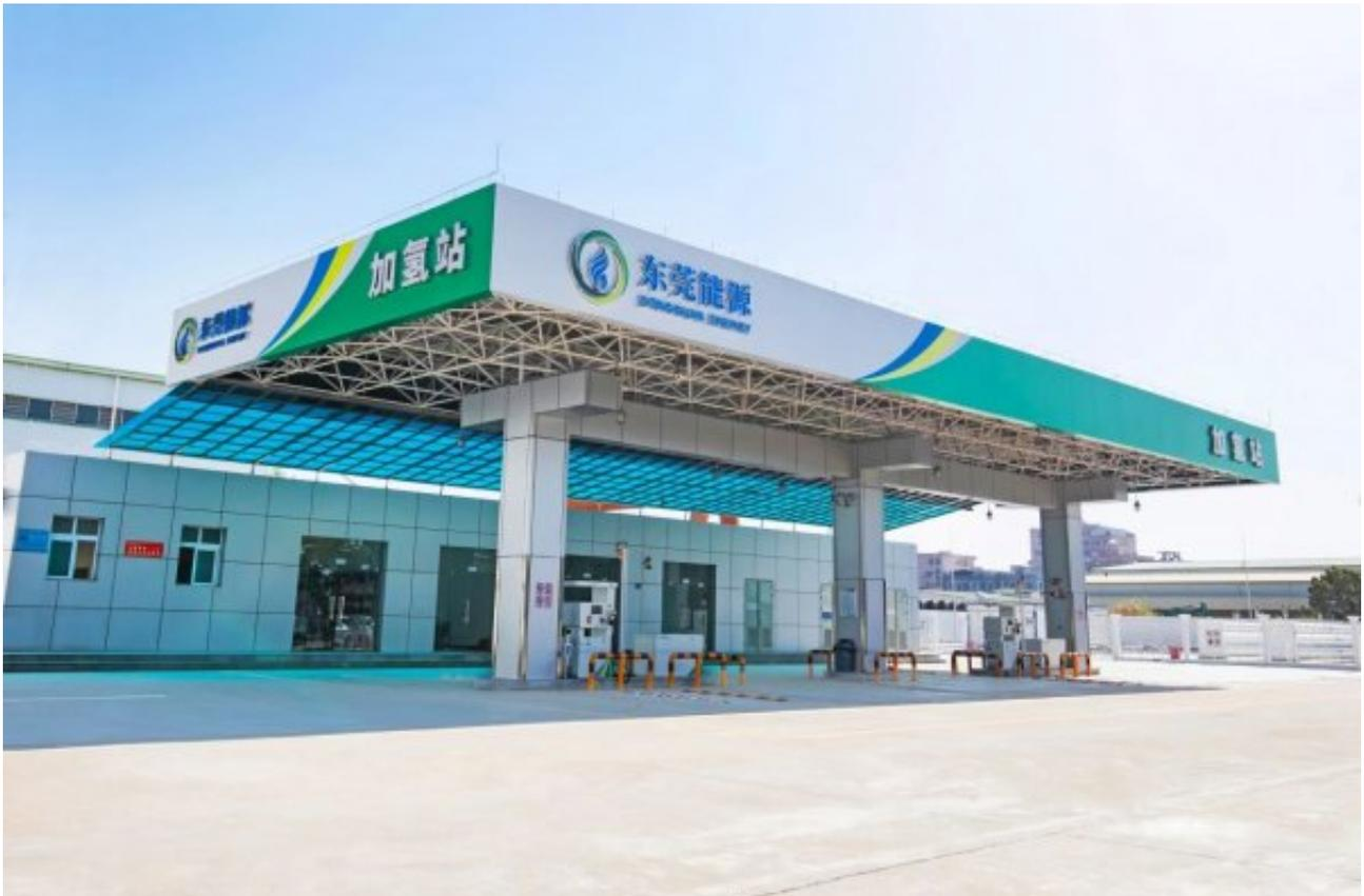
沙田加氢站加注能力达1000千克/天，其加注能力将有力保障东莞以及湾区中过往东莞的燃料电池汽车的用氢需求。此次成功获证，是东莞能源集团在氢能产业布局的关键一步，推动氢能交通迈向新高度。
