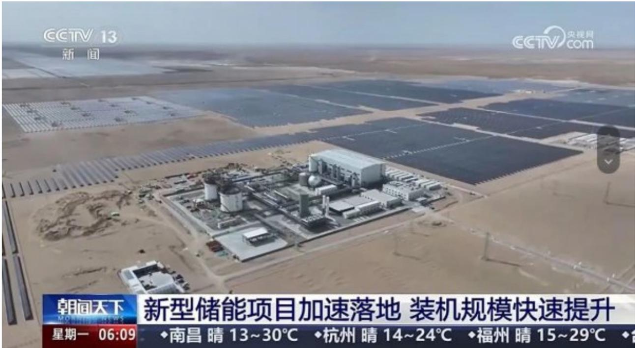
今年，政府工作报告明确将新型储能列为快速发展的新兴产业之一，并强调其作为国家能源战略转型的重要支撑作用。作为目前全球规模最大的液态空气储能项目，青海液态压缩空气储能示范项目采用国际领先的液态空气储能技术，通过压缩空气液化储能、膨胀发电的工艺路线，实现电能的大规模存储与释放，具有储能密度高、使用寿命长、环境友好等特点，是一项具有前瞻性的储能技术。相比传统储能方式，该技术具有充放电效率高、建设周期短、运行维护成本低等优势。该示范项目的建设，标志着我国在大规模储能技术领域取得重要突破，将为构建新型电力系统提供关键技术支撑。
