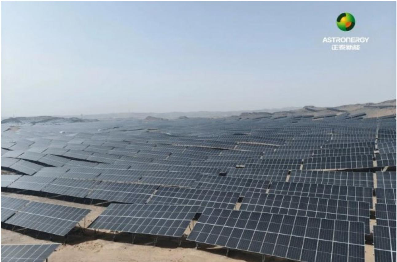
大唐中卫500MW源网荷储光伏项目坐落于腾格里沙漠边陲的宁夏中卫工业园区，总投资约20亿元，总装机容量达50万千瓦，占地约1.7万亩。项目建成后，年均发电量可达10亿度，相当于每年减少30万吨标准煤消耗，减排二氧化碳80万吨。
