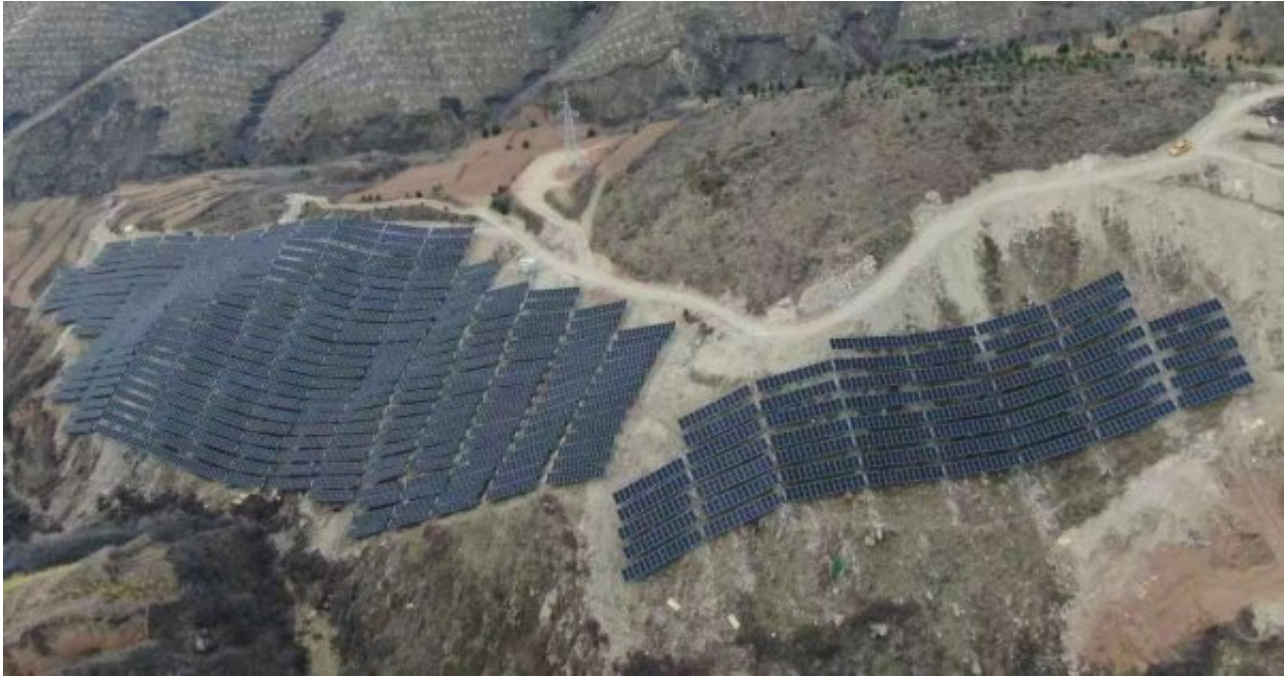
本项目为新能源100兆瓦光伏发电新建项目，光伏场区容量直流侧130兆瓦，交流侧100兆瓦。
