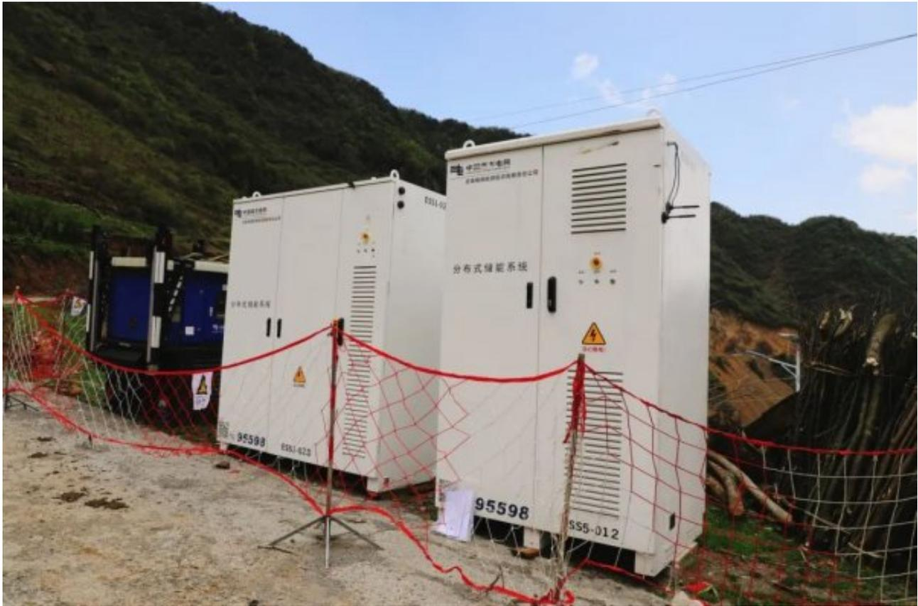
大关供电局计划生产部副经理曾正林介绍：“智能微电网”的运行原理，就是光伏板将光能转化为电能，储能设备将光伏电能存储入库，柴油发电机则作为“能量后备军”待命，整套微电网系统通过智能协同，形成“光能采集+电能存储+备用兜底”的完整链条，确保排危期间用户“不停电”。
