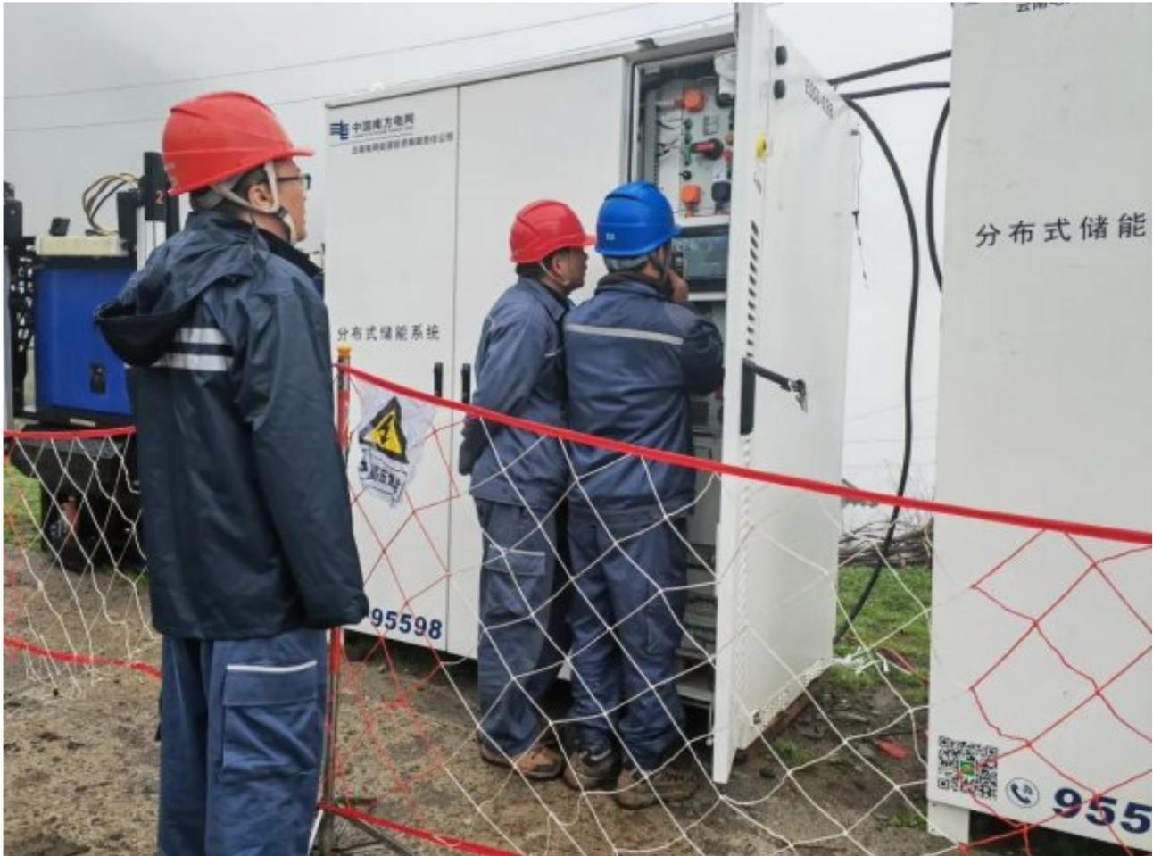
据了解，这是昭通市首次采用分布式光伏、分布式储能系统及柴油发电机，构建独立微型智能电网为用户供电。这一模式的应用，可以确保应急停电、电力抢险、供电紧张等特殊情况下用户安全、正常用电。
