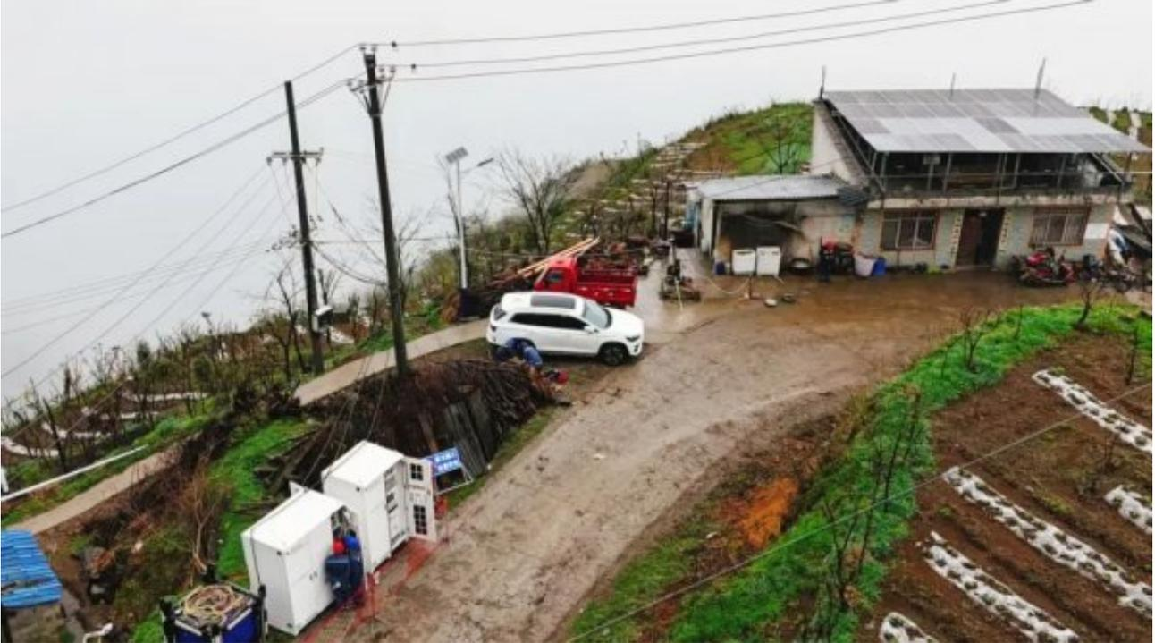
4月24日，记者来到玉碗镇出水村白沙社“智能微电网”建设现场，在农户杨洪明家屋顶，32块、89.6平方米的光伏板已整齐铺设；房屋不远处的空地上，两台储能设备与柴油发电机同步就位。工人们正用电缆将光伏板、储能设备与发电机按程序规范连接，同时对设备开展电脑联网调试。
