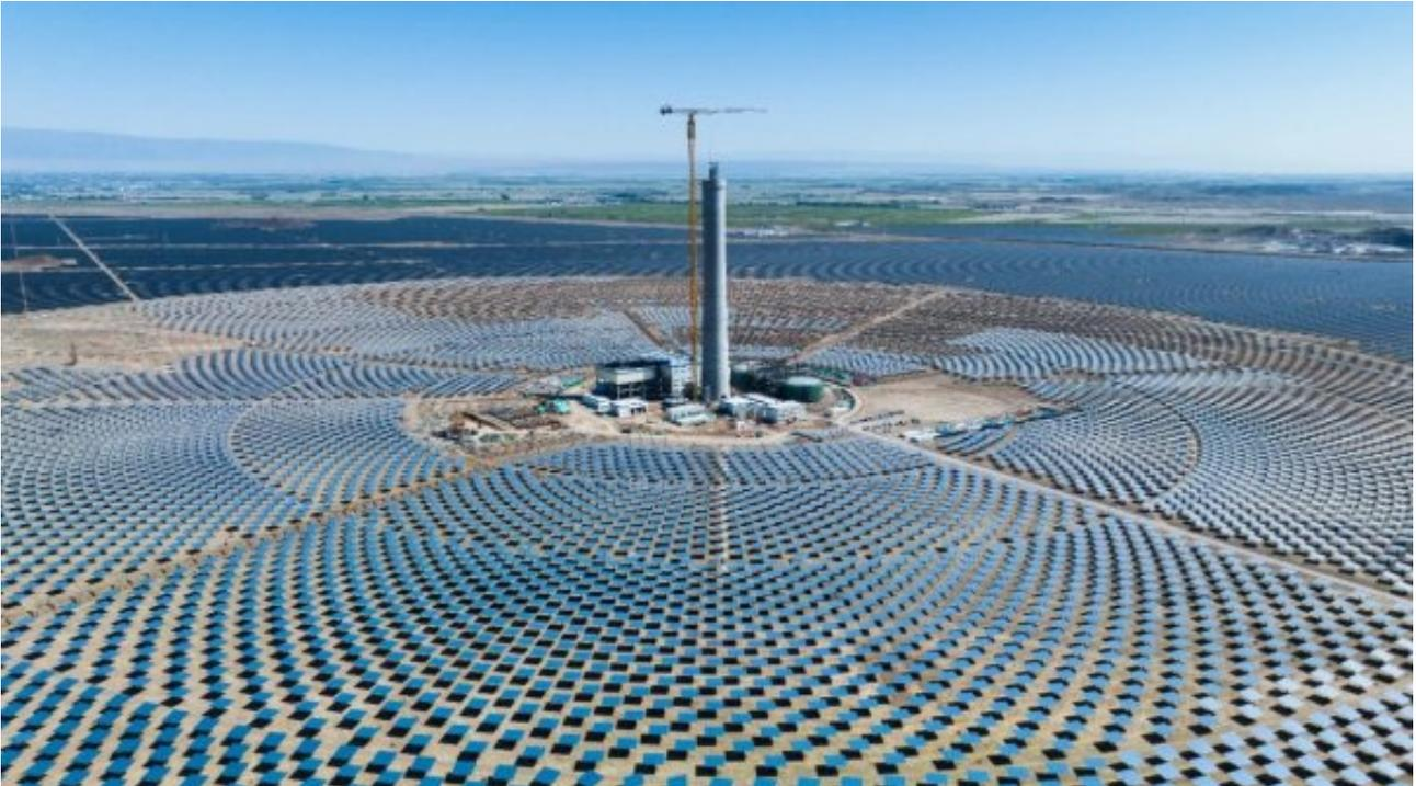
“今天迎来项目的重要节点。你看，储热型光热部分的吸热塔钢结构转换平台已顺利完工，吸热器的首批一榀钢结构也已成功吊装。”新华博泰（博乐）电力投资有限公司党委委员、副总经理罗正国指着吸热塔顶端说道。
