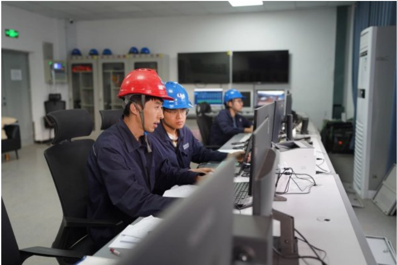
▲ 运维人员操作储能设备投运
