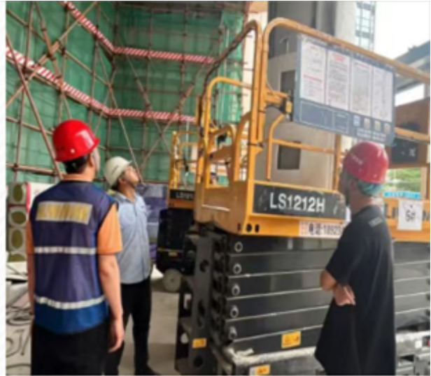
施工现场机械设备专项检查
