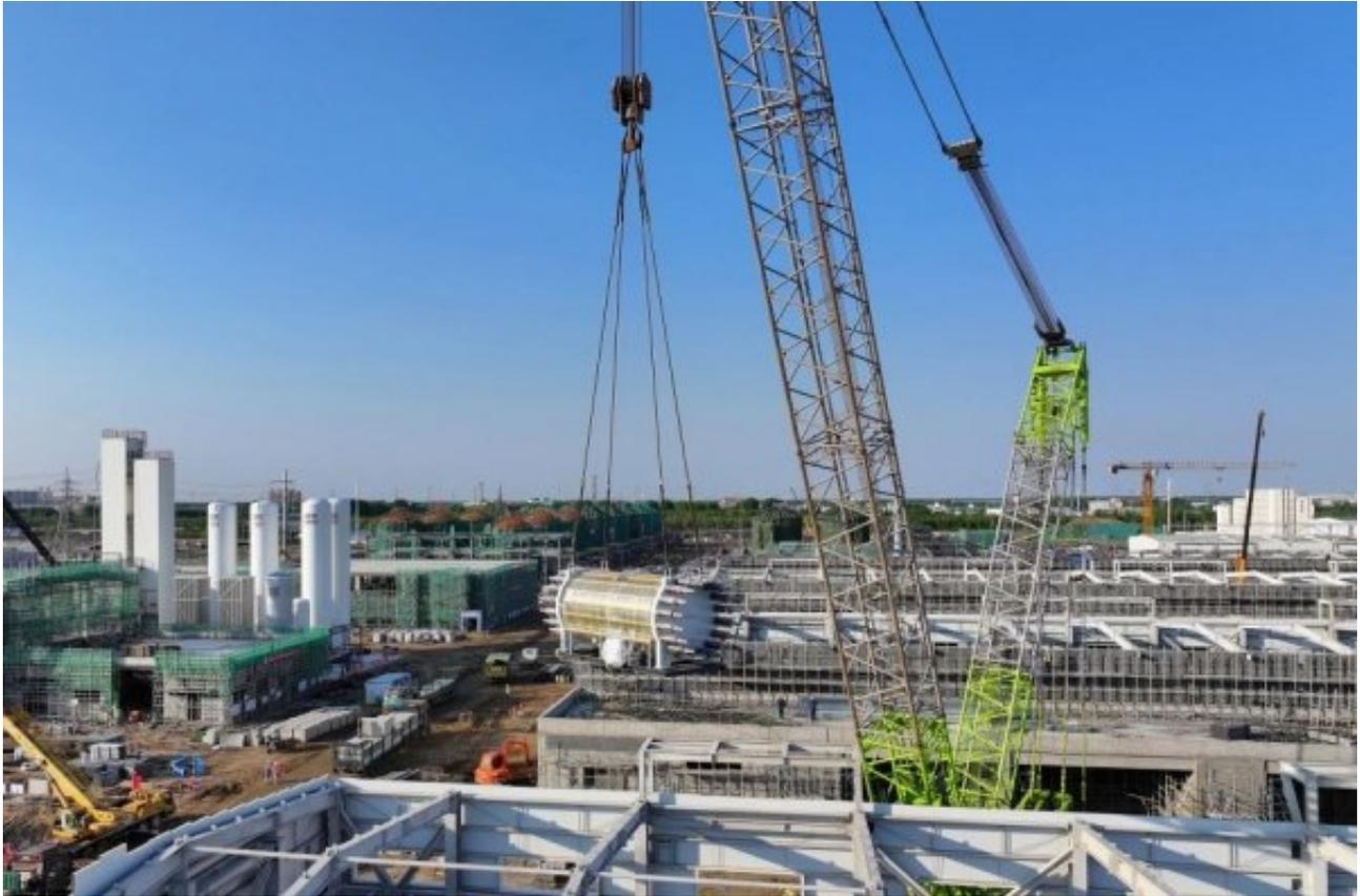
此次大型电解槽设备起吊重量50吨，采用超大型履带吊车进行吊装。松原项目公司及相关单位高度重视，提前制定吊装方案，积极开展专项安全培训，全方位抓实吊装作业安全管控，全力保障首台电解槽顺利吊装就位。
