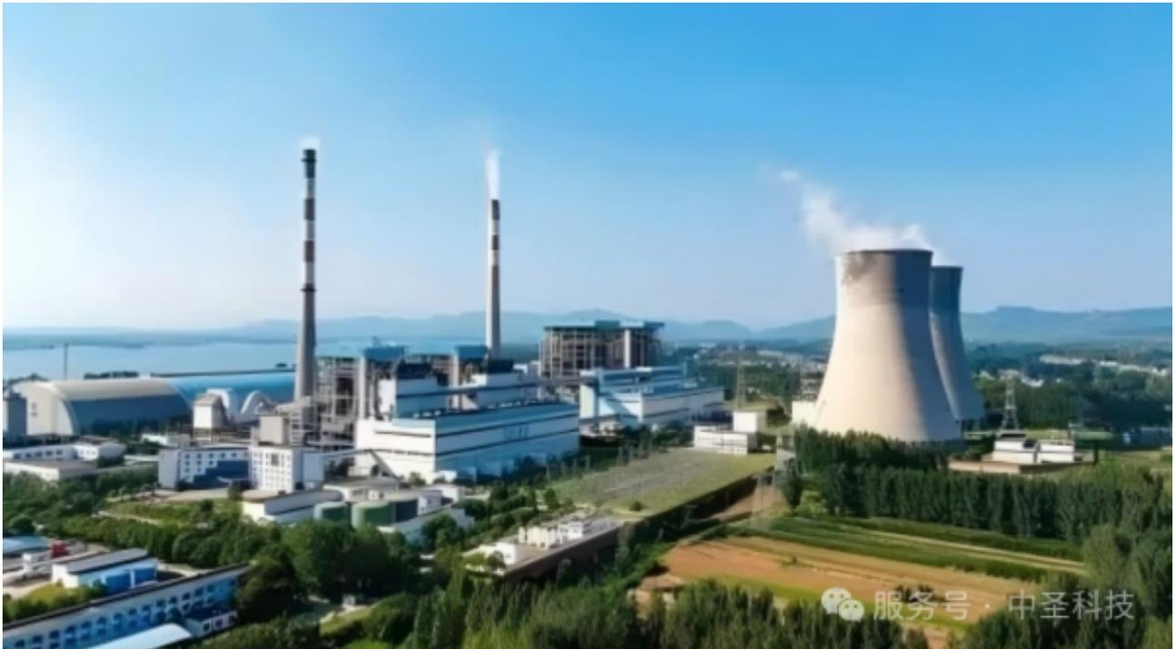
南阳天益发电有限责任公司#3机组生物质掺烧发电示范项目采用大型煤电机组生物质直燃耦合技术，需实现每小时不少于40吨生物质散料进入锅炉正常掺烧，并确保烟气通过现有机组的脱硝、除尘、脱硫设备达标排放。
