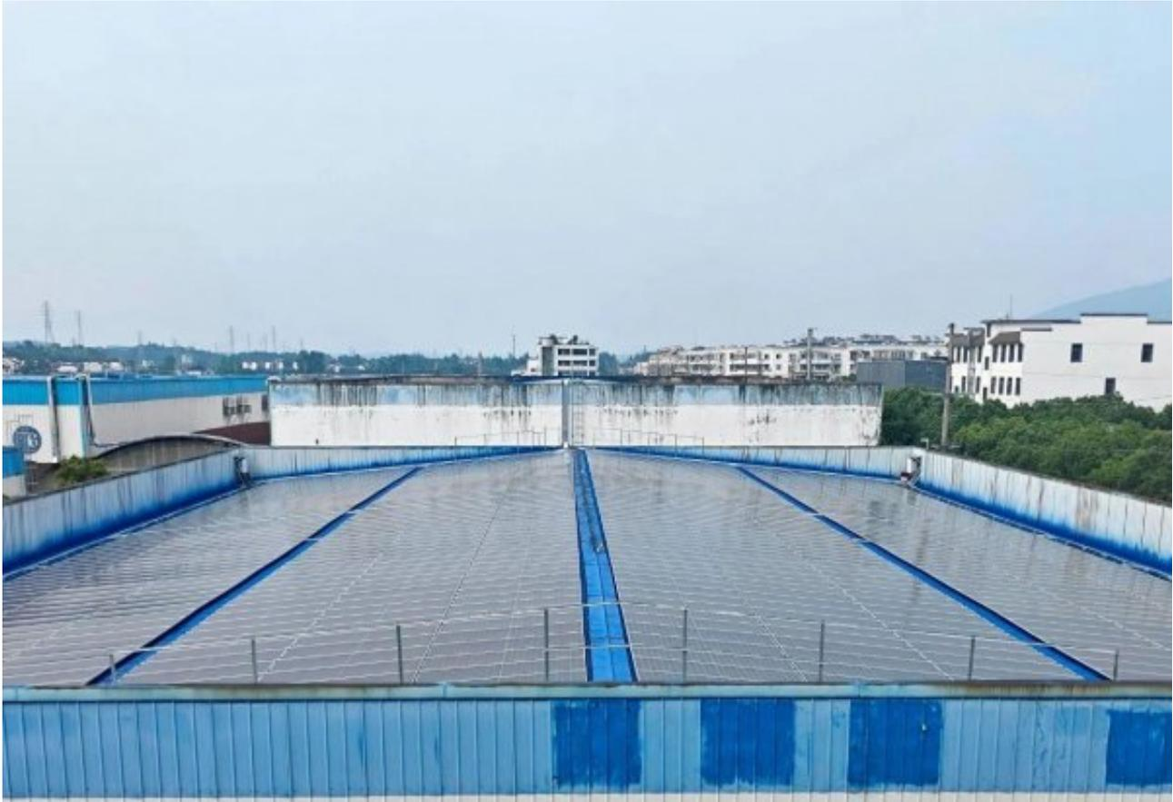
项目采用高效单晶双面光伏组件，搭配熊创自主研发的智能微电网系统，实现发电、调度一体化管理，能源利用效率提升15%以上。
