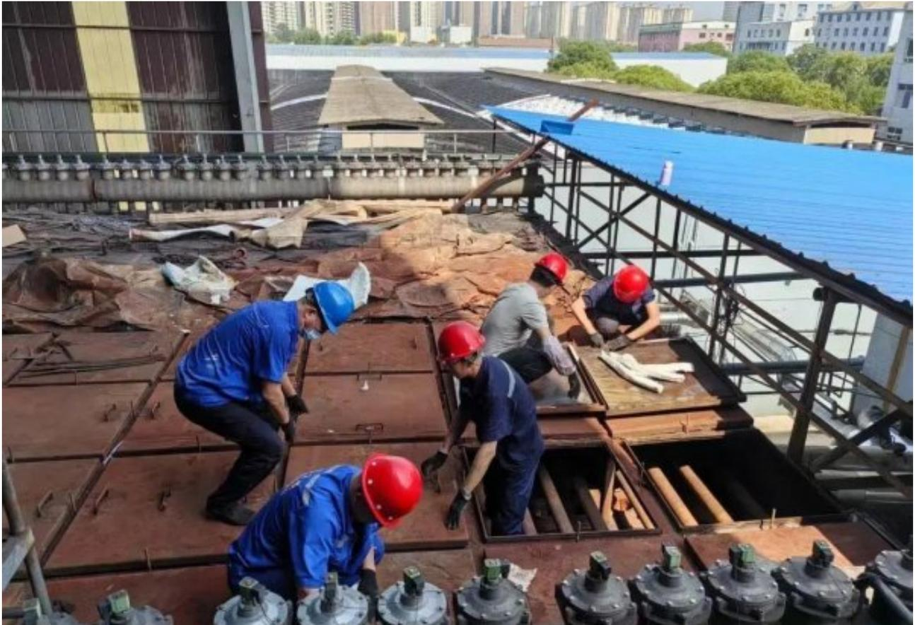
生物质气化炉作为可再生能源利用的核心设备，长期运行中易出现料层板结、灰渣堆积等问题，影响气化效率及安全性。为此，项目组制定了标准化清理流程，组织专业人员对炉内料层进行彻底清理，并重点检查了进料系统、排渣装置、燃气管道等关键部位。通过采用高压吹扫、机械清渣等技术手段，显著降低了炉内阻力，恢复了气化炉的最佳工作状态。
