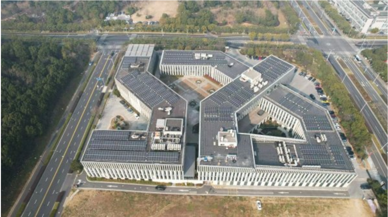
科技城工业坊480KW/1.72MWh储能电站：“智慧储能”降本增效
