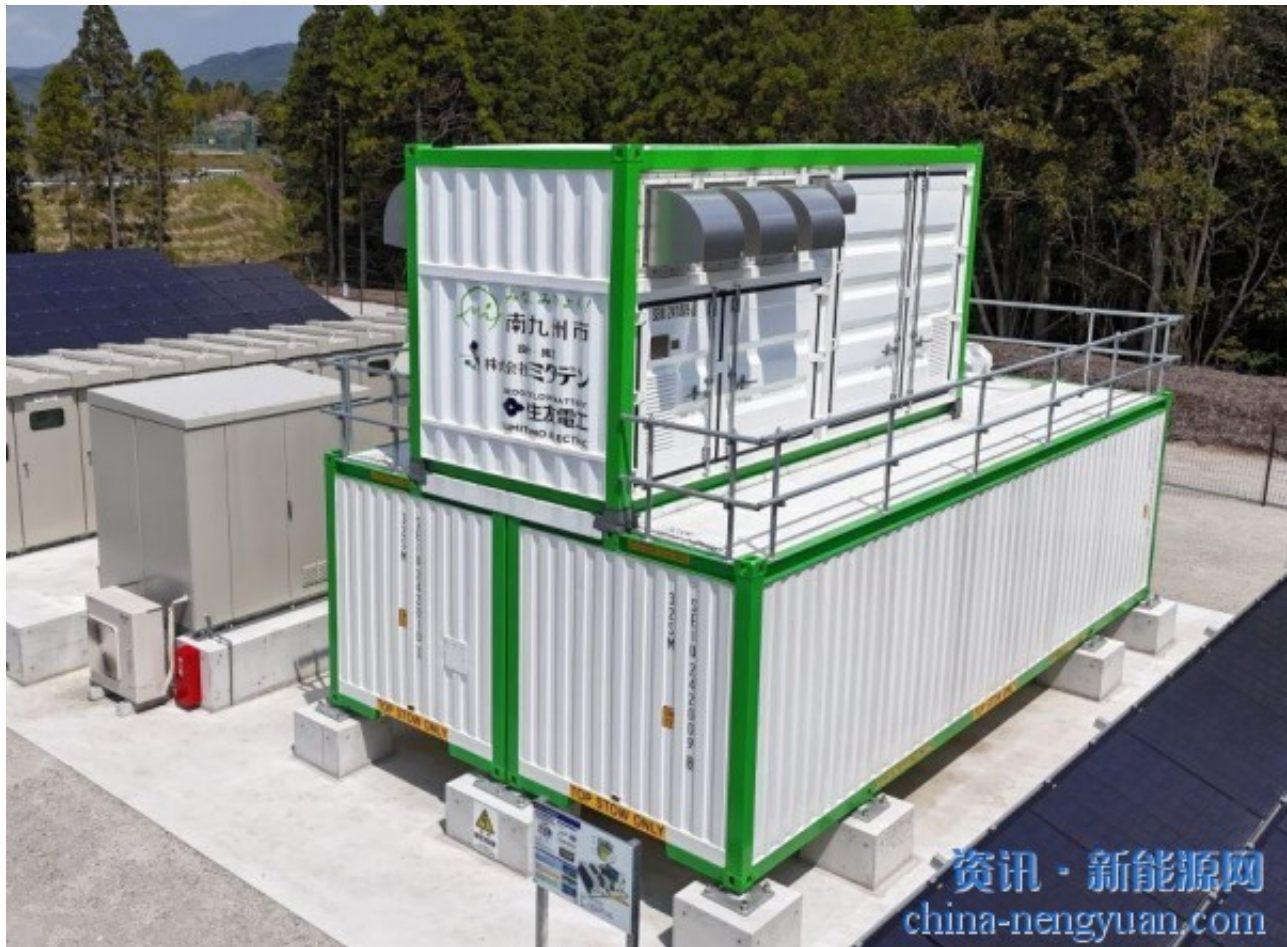
住友电气在日本南九州市的4小时液流电池系统。
