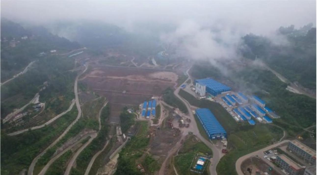
云阳建全抽水蓄能电站装机容量1200MW，枢纽建筑物主要包括上水库、输水系统、发电系统和下水库四部分，发电系统包括地下厂房系统建筑物和地面开关站等建筑物。本工程额定水头332.0米，为一等大（1）型工程。厂房开挖总长度177.4米，最大开挖高度57.3米。
