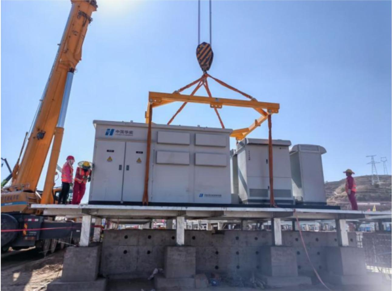
公司狠抓吊装现场安全管理，现场落实三级监督机制，确保作业许可、人员防护到位，筑牢安全防线。重点管控电池舱吊装就位，指派专人全程旁站监督，联合施工单位严查吊装设备及舱体状态，专人全程指挥调度，使用300吨吊车依规平稳起吊，全程稳控舱体姿态，严格规避碰撞风险。以“零事故、零缺陷”的高标准，历时54天圆满完成安装任务。
