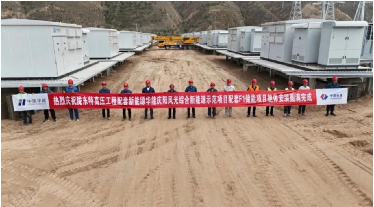
F1储能电站与升压站采用合建模式，项目总规模达300MW/1200MWh，由240个5MWh电池舱、60个变流升压一体舱和4个消防灭火方舱构成，通过12条35kV集电线路接入F1升压站。
