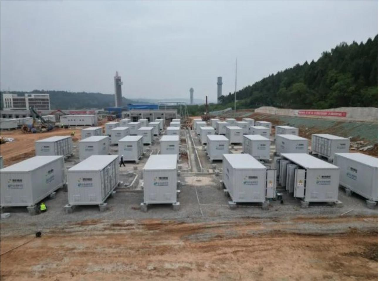
绵阳港旗储能电站（一期）是四川省示范重点建设项目，由绵阳港旗储能技术有限公司投资建设。项目选址于游仙区石马镇百胜村，总用地面积约75亩。其规划建设涵盖100MW/200MWh电化学储能以及15MW飞轮储能，并配套建设1座110kV升压站。自项目启动以来，各参建单位始终将“确保质量、控制安全”作为核心目标，齐心协力、攻坚克难，构建起“责任分明、考核清晰、奖罚分明”的闭环管理机制，为项目的高质量建设提供了坚实保障。
