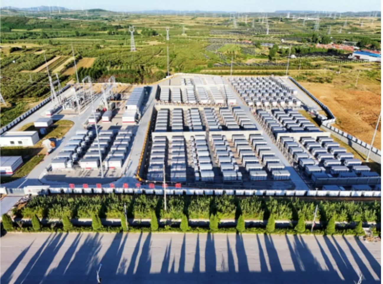
该项目位于山东省招远市阜山镇，装机容量320兆瓦/640兆瓦时，总占地面积约61亩，为山东省重大项目、储能示范项目，采用超级电容混合储能辅助调频技术，包含96套3.35兆瓦/6.7兆瓦时电池储能系统，1套2兆瓦/6分钟超级电容储能系统组成，利用低谷时段电网富余容量对化学储能设备进行充电。
