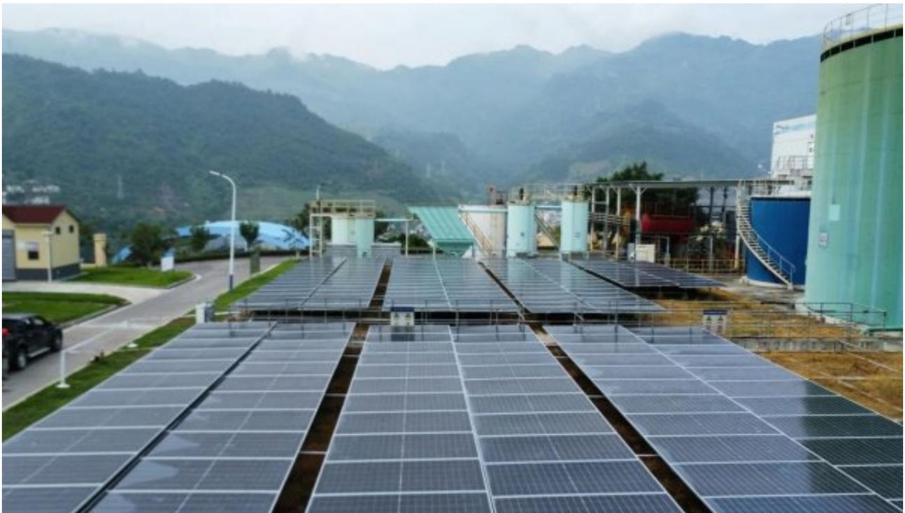
项目采用“自发自用，余电不上网”的运营模式，所发电量直接接入该厂380V低压系统，优先供给生产辅助用电，构建了“就地发电，就近消纳”的高效利用闭环。
