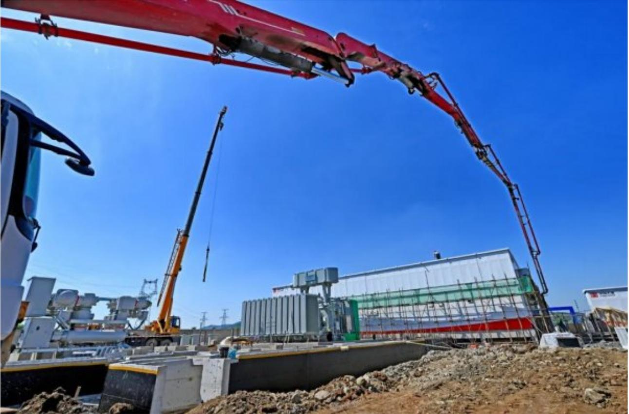
大唐本溪共享储能电站项目采用磷酸铁锂电池为主、飞轮储能为辅的设计，其中，磷酸铁锂装机98MW/196MWh，飞轮储能2MW/0.07MWh，并配套新建1座220kV升压站、59座电池舱，计划总投资超2.4亿元。
