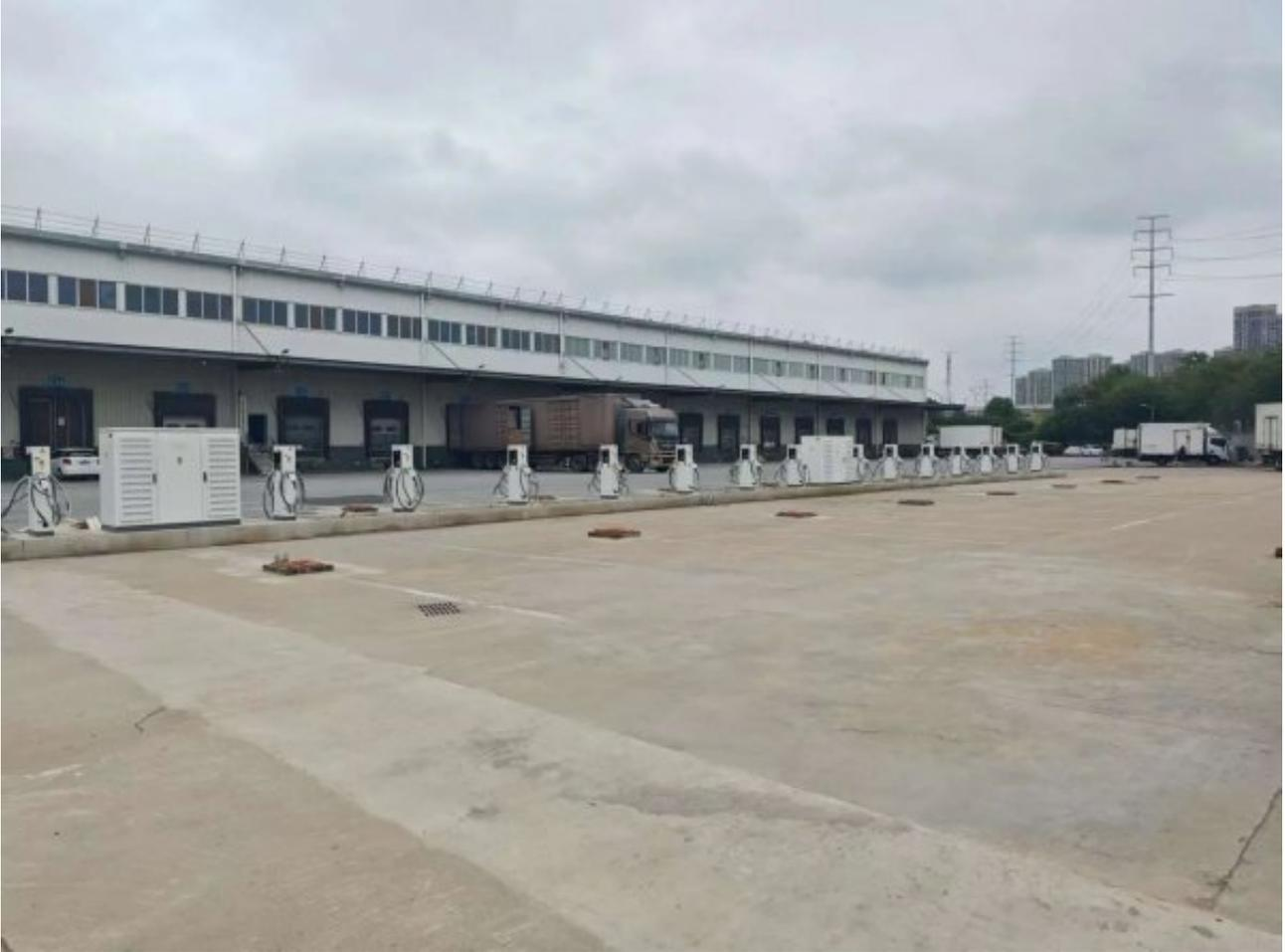
新充电站充分考虑了场地布局与车辆进出便利性，将站点建设在交通便利、位置空旷的4号库前露天停车场。站点配备全天候智能监控系统，可实时诊断设备运行状态，智能预警异常情况，最大程度保障充电安全。首批上线的98台充电桩，峰值功率980kw，30分钟即可快速补能，大幅提升充电效率，能够满足园区企业的新能源城市配送车辆和员工通勤私家车充电补能需求。
