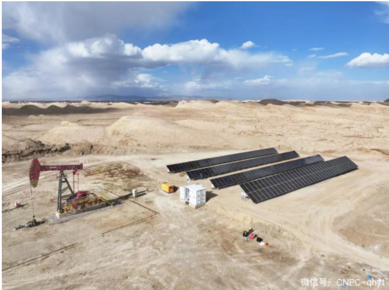
近日，青海油田首个钙钛矿组件组网微电网在采气二厂仙东8井成功落地。该零碳示范项目由油气工艺研究院牵头，采气二厂承建，深圳新能源研究院提供关键技术与设备支持，光伏总装机容量达101.8kWp，标志着青海油田在绿色低碳转型领域的又一技术突破。
