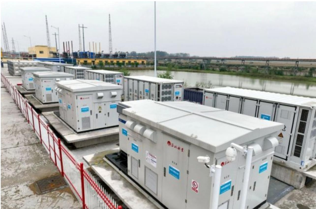
“从断电到无缝衔接应急保障，可以做到‘毫秒级响应’，是矿井供用电安全的‘终极防线’。”该公司保运区负责人表示。输出电压稳定、波动趋近于零，作为矿井的“生命第三电源”，极端外部断电情况下，该系统能瞬间切换启动，可保证矿井主通风机、瓦斯抽采泵站等“不断线”，副井提升机（满载）可全速运行2小时以上，为井下人员紧急撤离、设备应急处置提供坚实安全保障。
