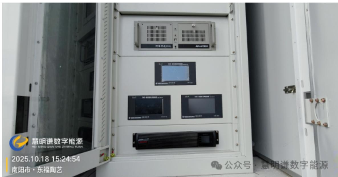
慧明谦EMS站控能量管理系统=混合储能的"神经中枢"：让锂电"短跑"、钒液流"马拉松"各司其职；让安全、收益、扩容、运维全部在线。
