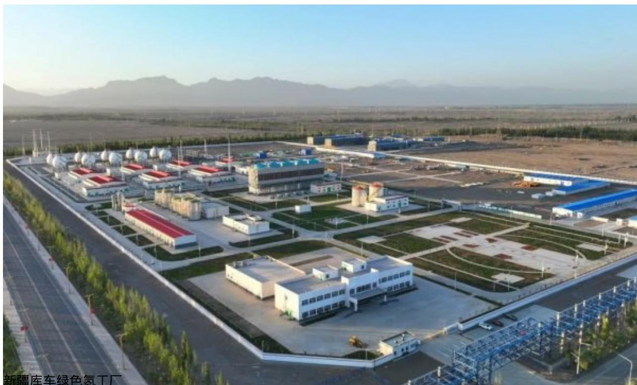
该项目使用260MW的由可再生电力供电的电解槽，生产用于炼油厂的工业氢气。
