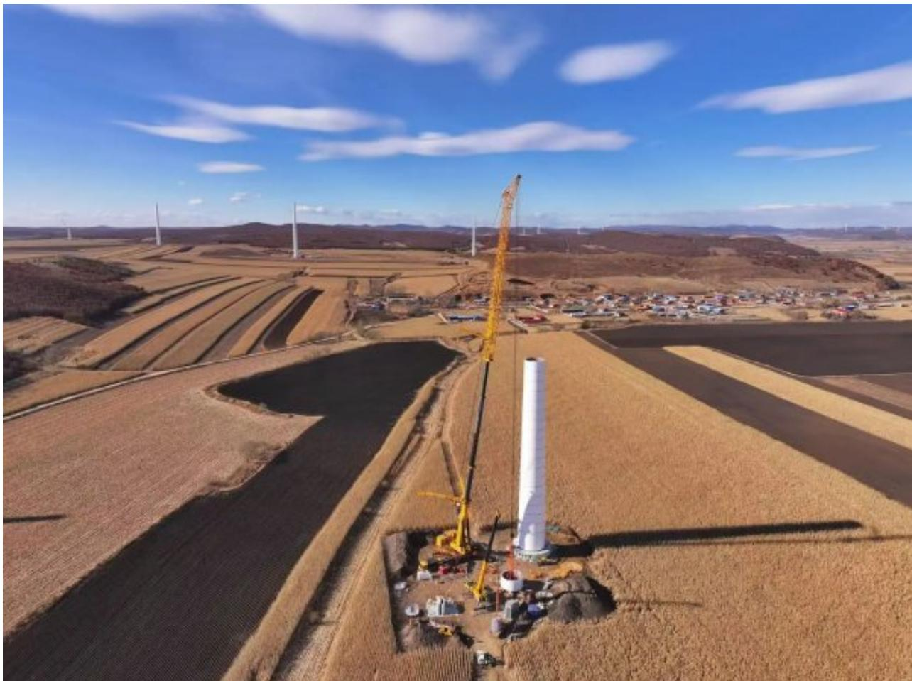
深秋的扎兰屯大地，寒意渐浓，但内蒙古能源集团100万千瓦风储项目施工现场却热潮涌动。日前，记者走进内蒙古能源集团扎兰屯100万千瓦风储项目施工现场，塔吊林立，一片热火朝天的忙碌景象，目前500千伏升压站正在进行设备安装等各项工作。各个施工现场，有条不紊的推进，风机基础的浇筑、风机混塔段的吊装、风机机舱叶片吊装等工作，包括后期的电装调试等正在加快进行。
