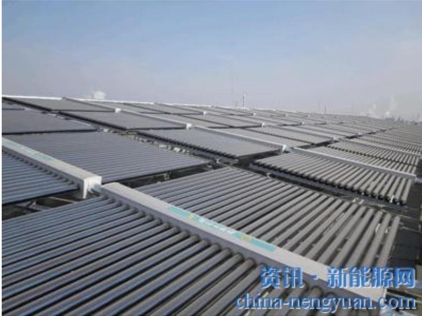
近日，桑乐公司又一太阳能热水工程在山东淄博顺利通过验收，并交付使用。此工程为30吨横排联箱式太阳能热水工程，是桑乐公司按照沂源瑞阳制药有限公司的要求设计并施工。本工程在桑乐沂源县经销商和公司工程技术人员的配合及努力下，历经20余天的紧张施工，保质保量，按时交付使用。经试用，得到了瑞阳制药有限公司领导及员工的一致好评。
