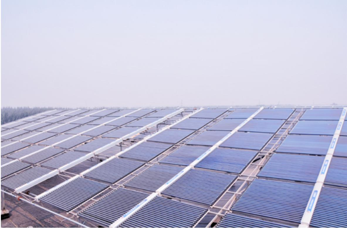
力诺瑞特山东金号织业有限公司染整车间工业热水工程一期项目将8583m<sup>2</sup>太阳能集热器集中安装在整染车间2.5万平方房顶，布置既不影响厂房与周边景观配套风格，也不影响房顶防水层。项目根据其自身的特点采用了分散式集热、集中储热供热的方式，融入了三腔集热管、远程监控、变频恒压循环等十几项新型技术，不仅集热效率高而且便于控制，同时通过冷水压力与变频机组实现集热矩阵的运行压力，节约了泵的运行费用。
