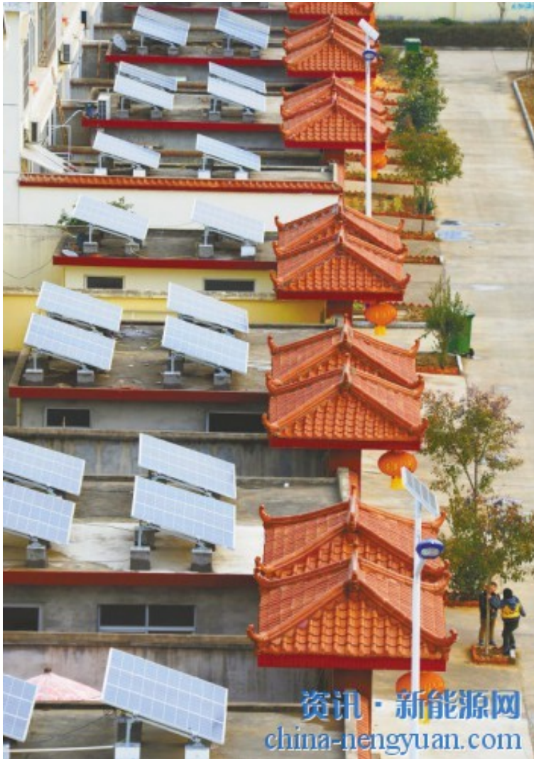
图为青南“光伏发电村”连片屋顶。
