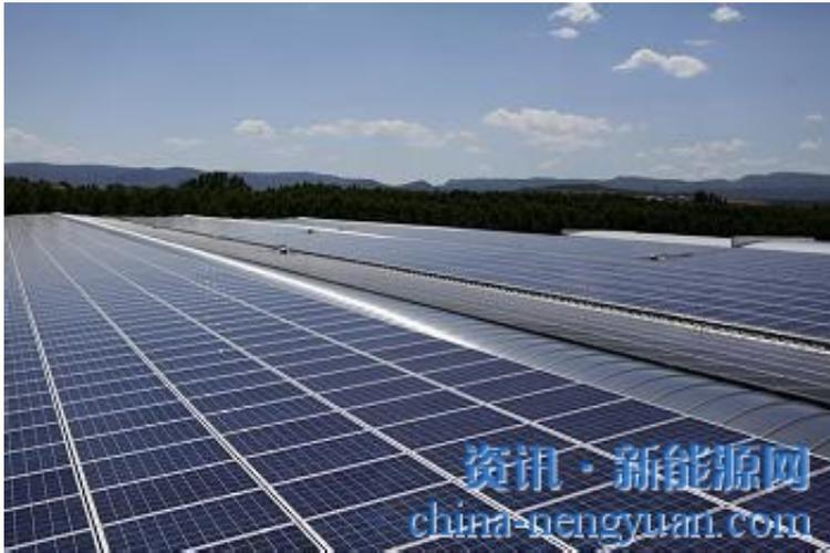
分布式发电通常是指利用分散式资源，装机规模较小的、布置在用户附近的发电系统，它一般接入低于35千伏或更低电压等级的电网。分布式光伏发电特指采用光伏组件，将太阳能直接转换为电能的分布式发电系统。
