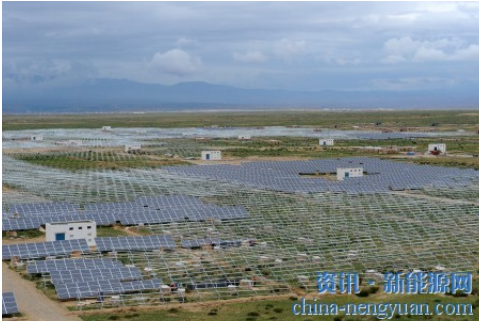
龙羊峡水光互补320兆瓦并网光伏电站一号区支架安装现场
