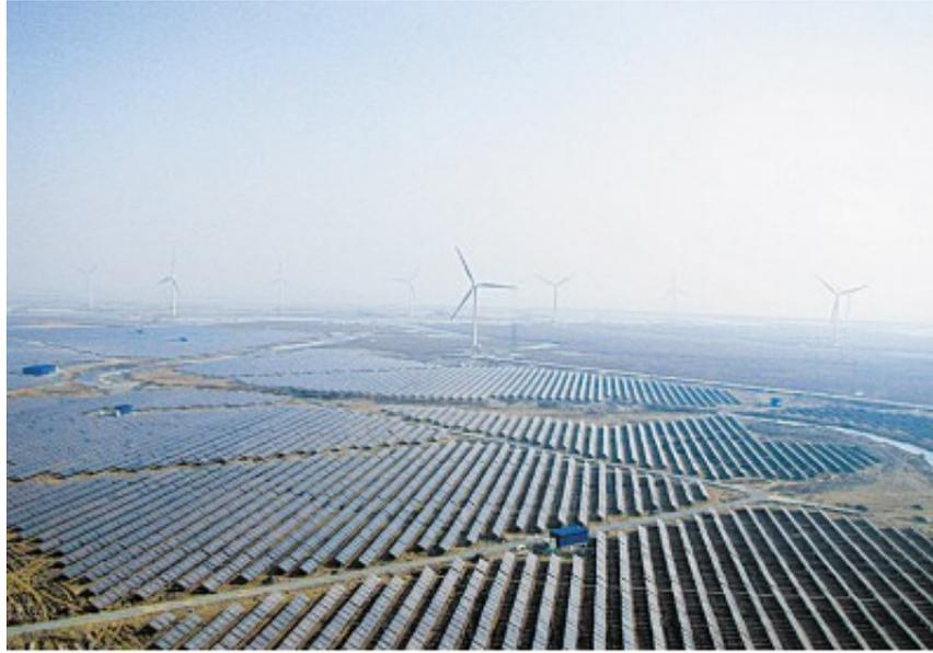
江苏省大丰市利用沿海滩涂资源，建设了总容量220兆瓦（风电200兆瓦、光伏20兆瓦）的全国规模最大的“风光互补”绿色能源基地。即利用风电场风机间隙的土地建设光伏电站，根据风资源夜晚强白天弱、光资源白天强夜晚弱的特点，取长补短，优化电网负荷，保护电网。
